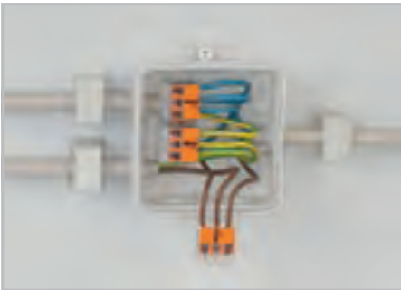
Электромонтаж тонких многожильных проводников в распределительной коробке.
