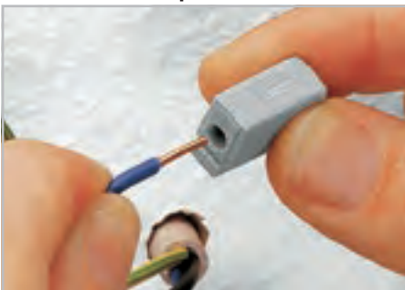
Выполнение соединения: вставьте зачищенный одножильный проводник в круглое отверстие до упора.
