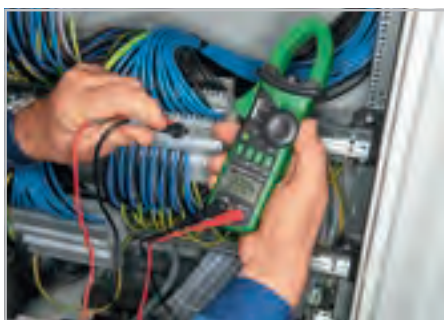
Проверка наличия напряжения в распределительном шкафу
