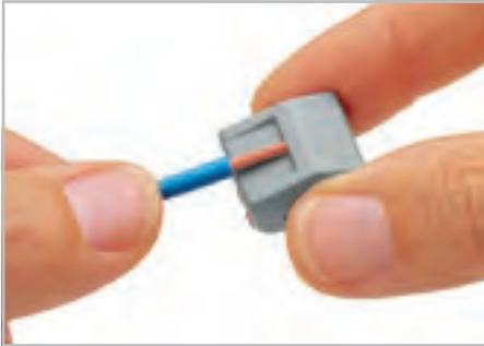
Зачистите проводник на 9 ... 10 мм.
