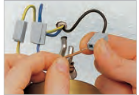
Отключение: нажать кнопку и извлечь проводник.
