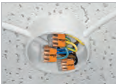
Распределение питания для потолочных светильников
