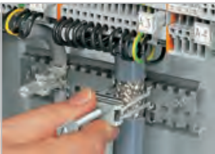
Установка дополнительного зажима для экрана.
