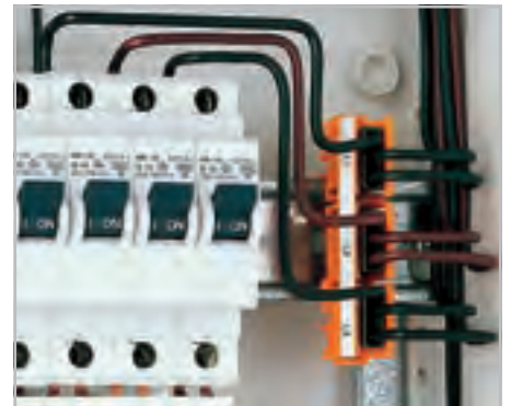
ЗАФИКСИРОВАННОЕ ПОЛОЖЕНИЕ - на DIN-рейке 35 мм
