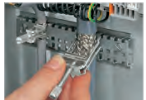
Для удаления зажима, отвинтите винт до освобождения храпового механизма, затем немного потяните зажим и снимите его.
