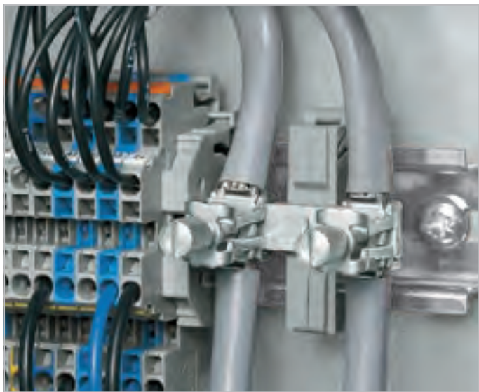
Держатель с контактной ножкой, шина параллельна рейке.
