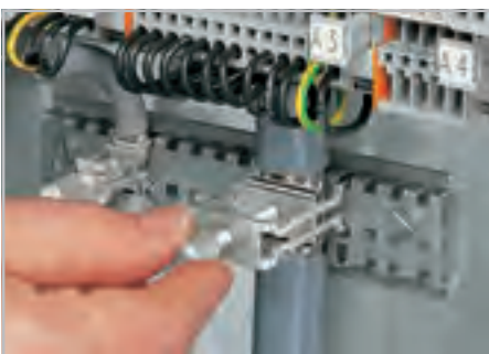
Затяжка/удаление зажима для экрана.
