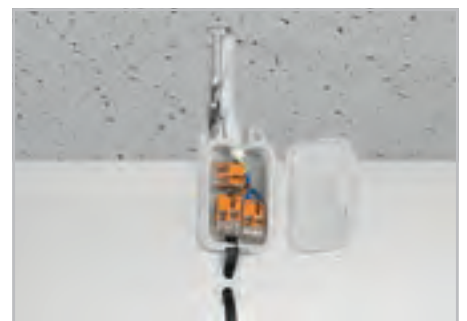
Подвесное присоединение светильников в подвесных потолках
