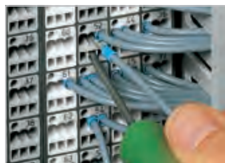
Подключение проводников с наконечниками.
