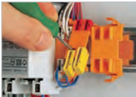
Извлечение клемм PUSH WIRE® из держателя.
