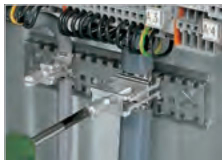
После соединения необходимо затянуть крепежный винт для завершения установки. Рекомендуемый момент затяжки: 0,5 Нм
